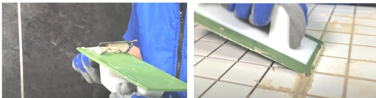
Рис. 28. Заполнение швов затиркой при помощи резинового шпателя
